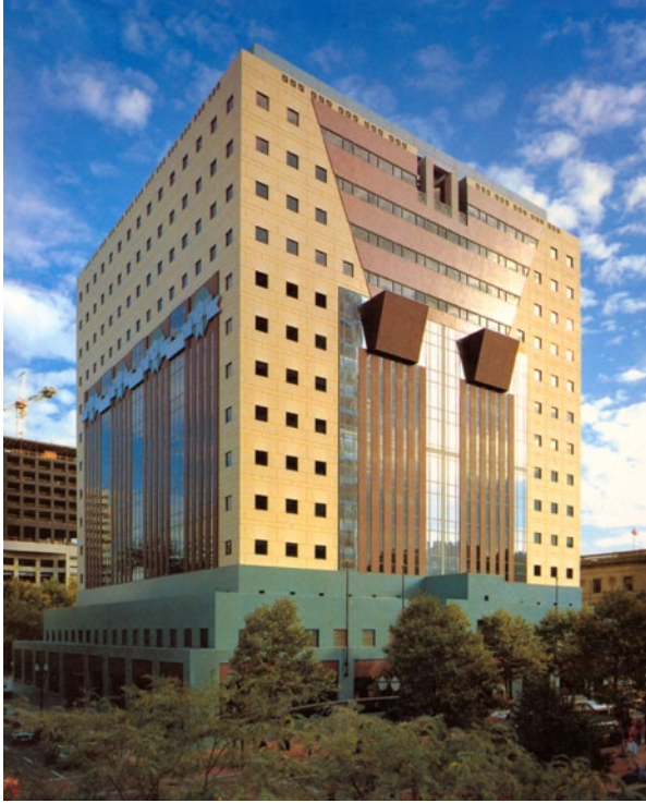
[2.13] Michael Graves – ‘The Portland Building’, Chicago – 1980/1982, in het oorspronkelijke ontwerp stonden ook nog tempeltjes op het dak gepland die de luchtkokers en dergelijke moesten camoufleren (Jencks 1984: p.7).
